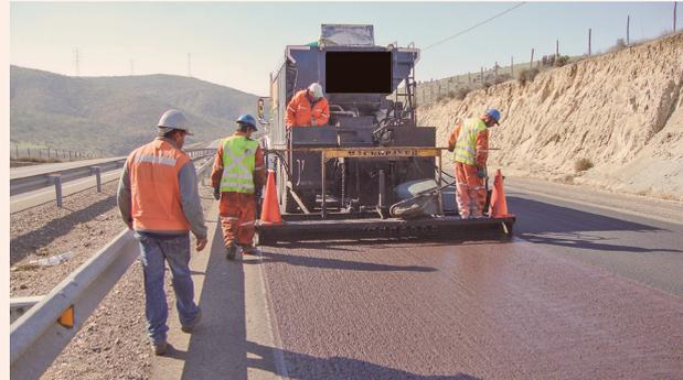
Se obtienen emulsionando el asfalto en agua, siendo posible trabajarlos en frío. Nos ofrecen grandes ventajas económicas y ambientales al reducir significativamente el consumo energético y de materiales, así como los plazos de construcción. Las técnicas de pavimentación con emulsiones permiten pavimentar y mantener muchos más kilómetros con un mismo presupuesto. Casi la mitad de nuestra red vial pavimentada se ha construido con algunas de estas técnicas.
